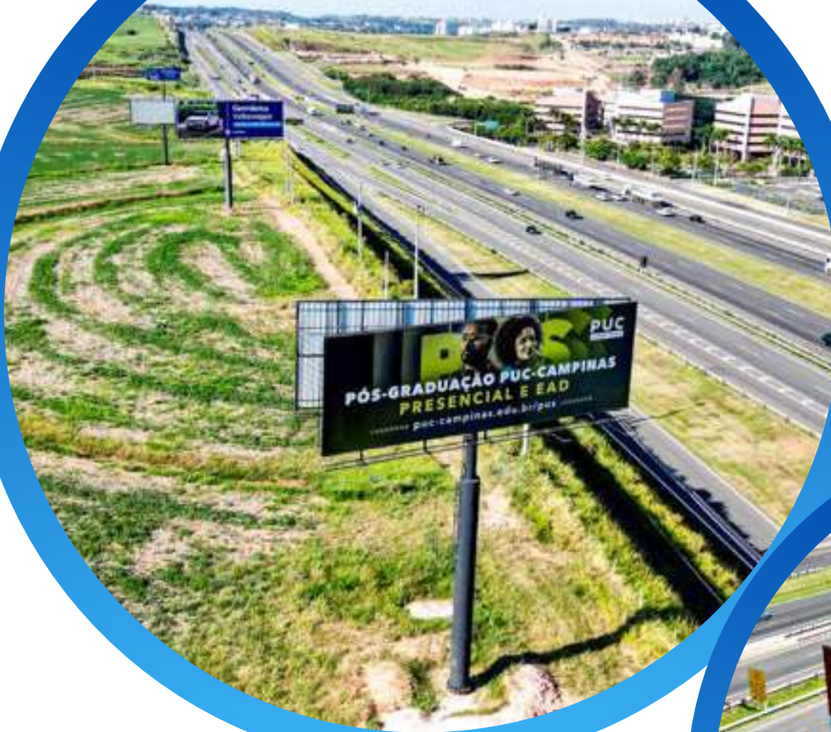
CAM5 Rodovia Dom Pedro (km 131+800m Norte)
